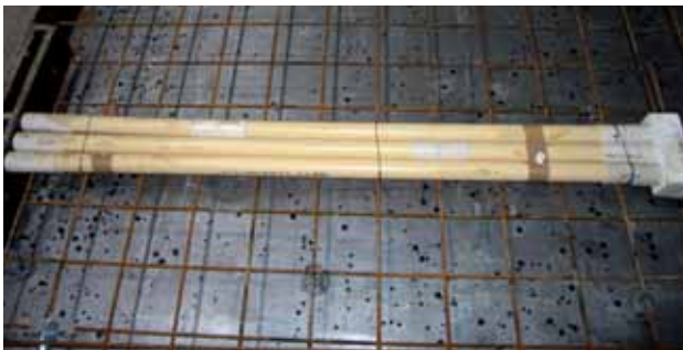
Figur 20. Hvor rørene munder ud på elementets flade anvendes ofte udsparingsklodser af ekspanderet polystyren. Billedet viser fremføring af 3 rør til en installationskanal. Væggen er enkeltarmeret, og rørene er fastholdt til armeringen med ståltråd, så de ikke forskydes under støbningen.
