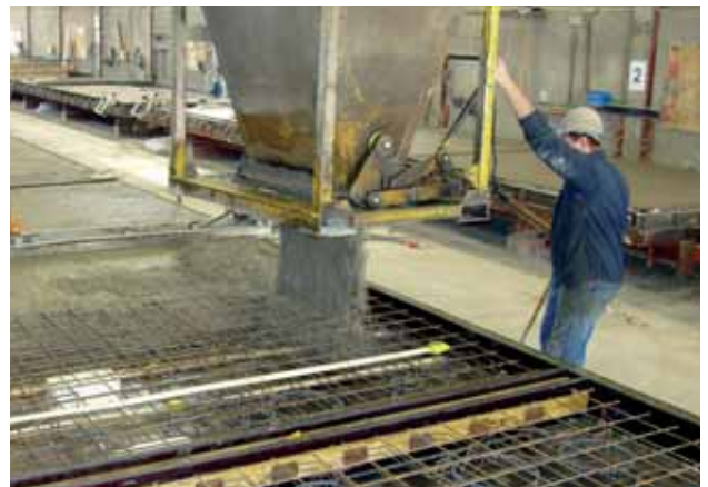
Figur 29. Selve udstøbningen af et betonelement medfører store belastninger af indstøbningsdelene, og der stilles derfor store krav til fastholdelsen. Fastholdelsen skal ikke alene forebygge sideforskydning af indstøbningsdelene, men skal også modstå opdriften i betonen, som er 2½ gang større end opdriften i vand.
